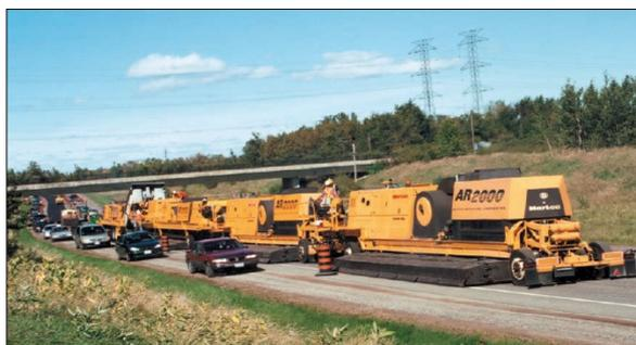
Equipamento pesado de processamento móvel com reuso no local evita transporte
